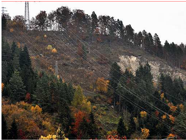
Abbildung 60: Gestaltung der Vegetation unter einer Stromtrasse am Neckar als beweideter lichter Wald, um Begehbarkeit und Wartungsarbeiten zu erleichtern.
