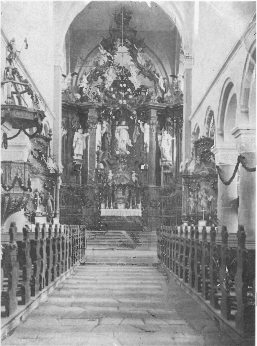
Abb. 1 Ehemalige Abteikirche Schwarzach. Blick durch das Mittelschiff nach Osten; 1876. (Landesdenkmalamt Karlsruhe, Neg. Nr. 522/22 a)
