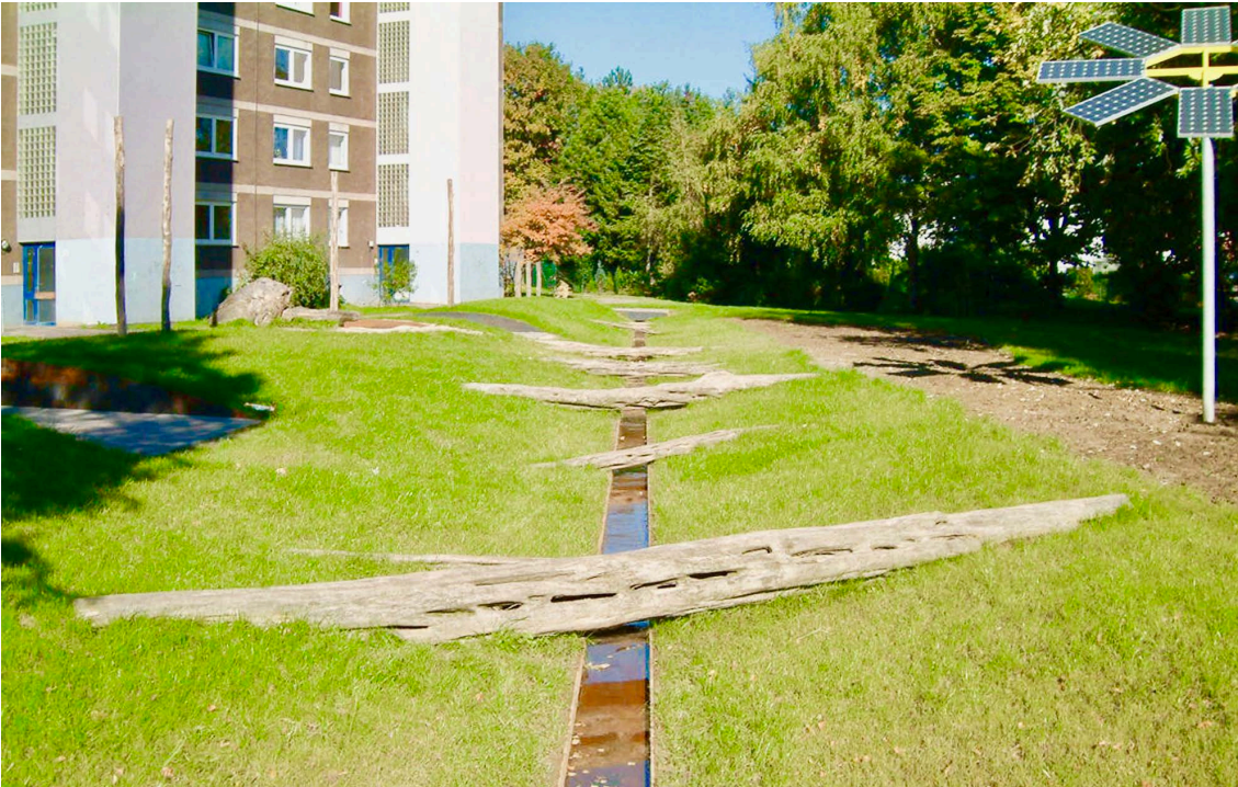
Abb. 9: Oberflächige Regenwasserableitung in Gorbitz, Dresden. Quelle: Landschaft planen + bauen NRW GmbH
