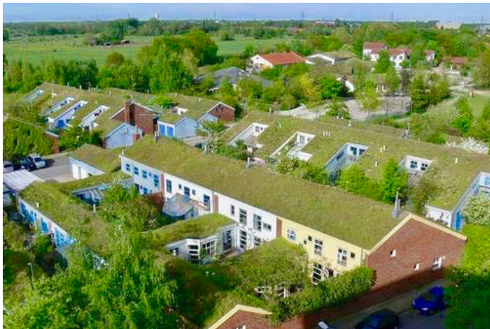
Abb. 8: Grasdachsiedlung Laher Wiesen in Bothfeld, Hannover Quelle: Hannoversche Allgemeine Zeitung (Michael Zgoll)
