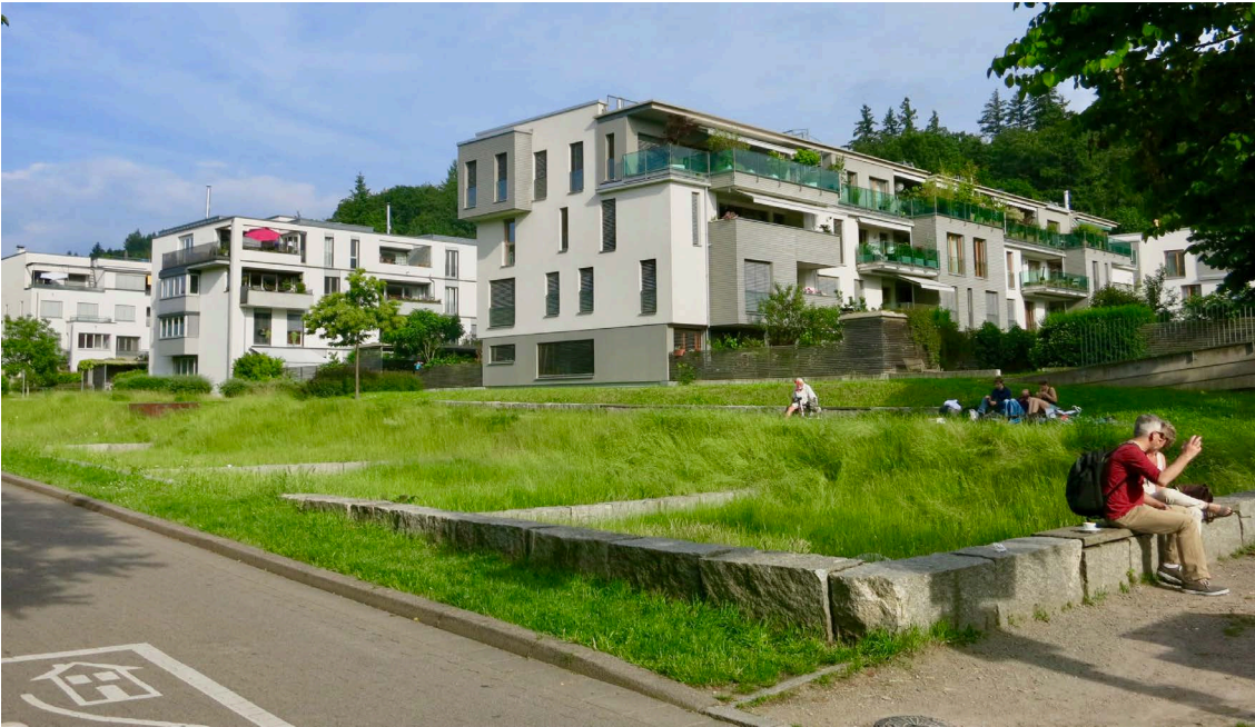
Abb. 6: Zu Freizeitwecken genutzte Versickerungsmulde in der Wiehre, Freiburg. Quelle: Kirsten Hackenbroch
