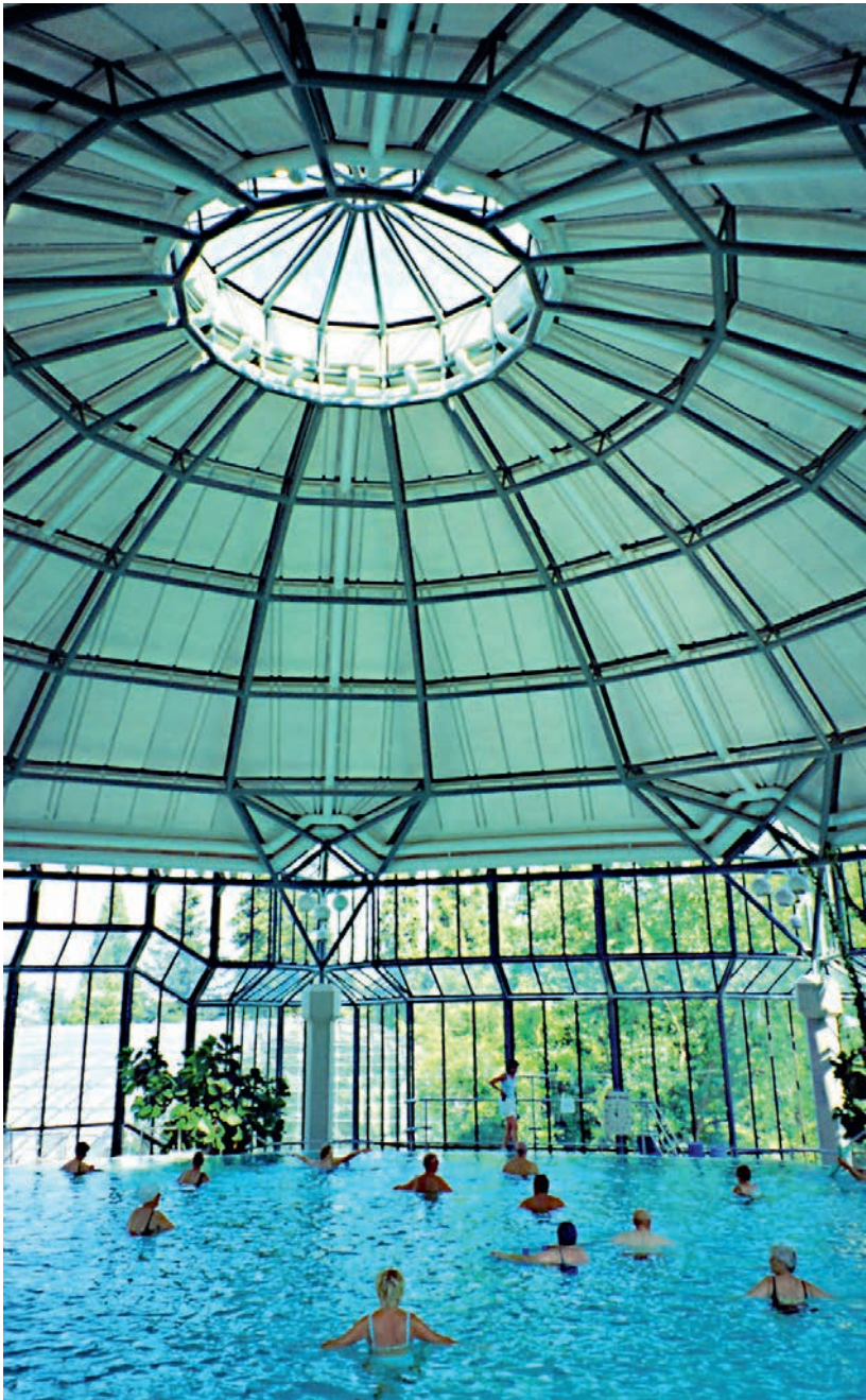
Abb. 27: Thermal-Bewegungsbad in Badenweiler, Architekt Walter Strop (1977–81).
