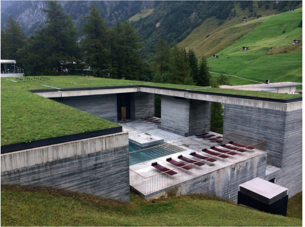
Abb. 12: Therme in Vals, Ansicht des Außenbereichs.
