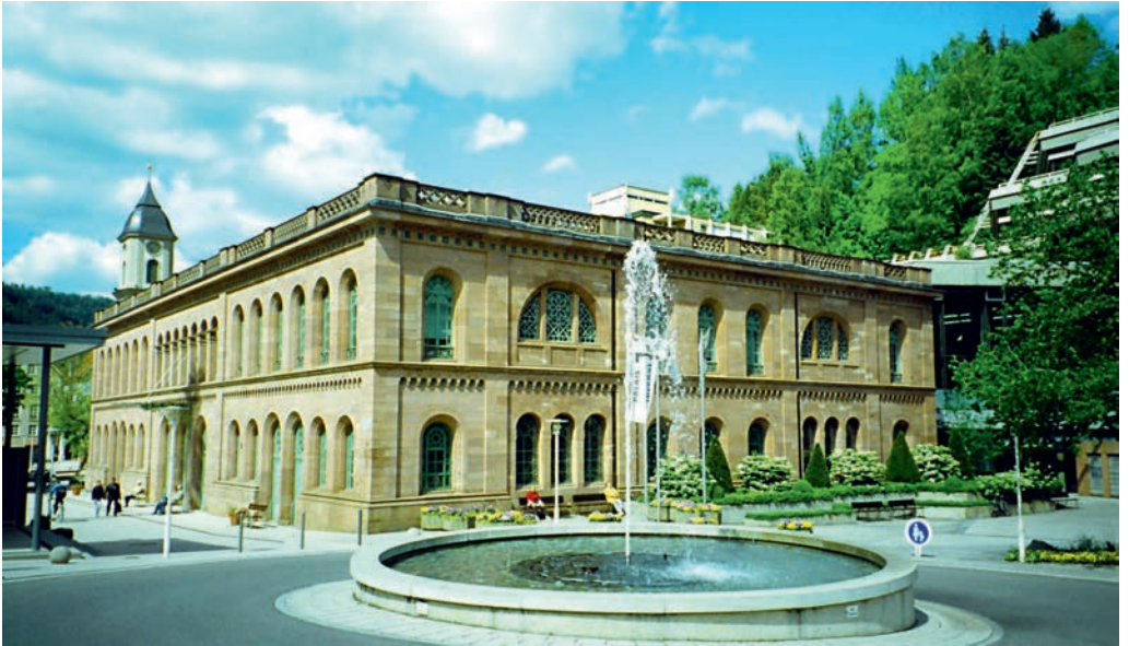
Abb. 22: Graf Eberhardsbad in Wildbad (seit 1995 Palais Thermal), Architekt: Nikolaus Friedrich von Thouret (1839–42).
