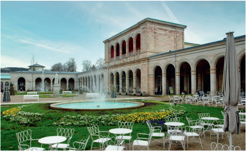
Abb. 14: Kursaal in Kissingen, Architekt: Friedrich von Gärtner (1834–38).
