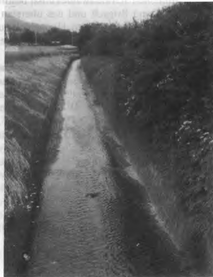
Fig. 3: Zähringer Dorfbach (ZÄH), vollständig vom natürlichen Untergrund abgeschnitten durch Pflastersteine und Betonschalen, außerdem häufiger Wechsel im Wasserstand bis zum Trockenfallen. Dieses zur Abflusssrinne degradierte Fließgewässer ist entsprechend artenarm.
