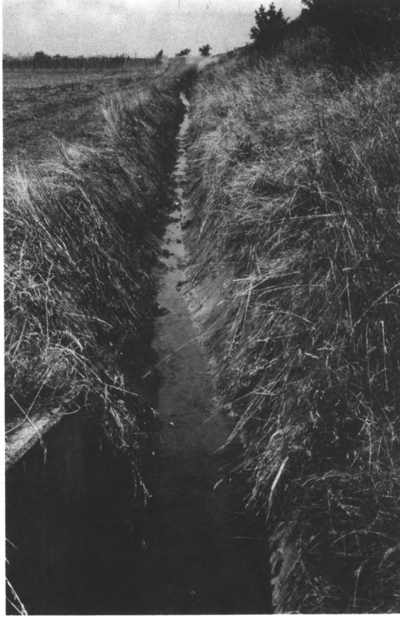
Abb. 11: Ausgeräumter Graben mit Steilböschungen bei Buchholz (Lkr. Emmendingen).
