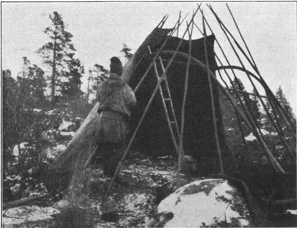
Abb. 105 Fotograf Wilhelm Crahmer , „Aufschlagen einer Zeltkota: Die Tragkonstruktion.“ (oben), „Aufschlagen einer Zeltkota: Die Tragkonstruktion mit Stangen umstellt. Das Zelt ist bereits zur Hälfte mit dem Kotatuch bedeckt.“ (unten) Foto veröffentlicht in Zeitschrift für Ethnologie 46.1914:792
