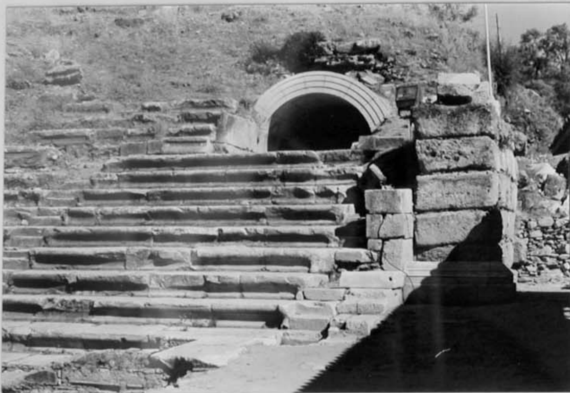
Abb. 27 Tonnengewölbe des östlichen Zugangs zur Cavea
