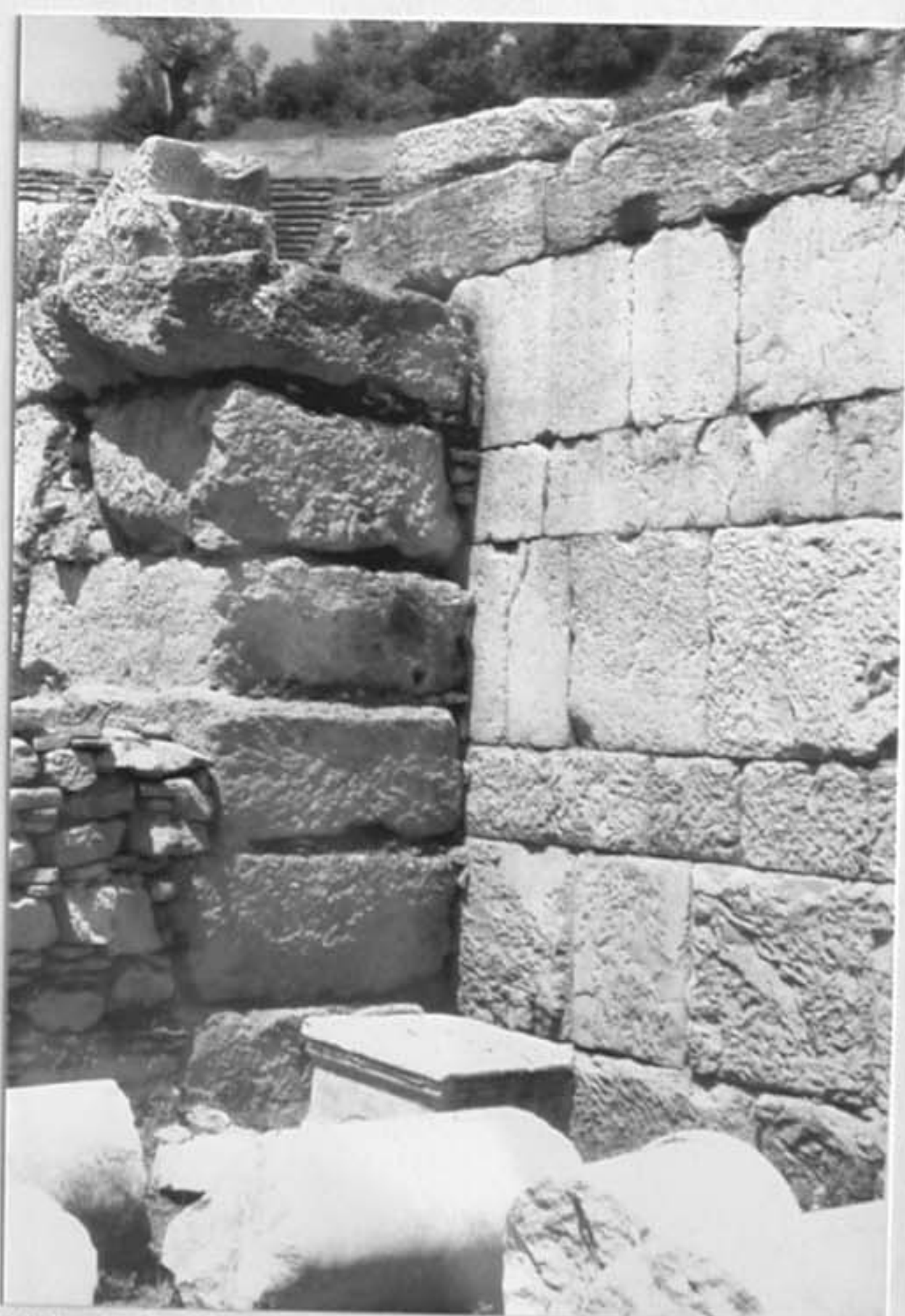
Abb. 43 Stoßfuge zwischen Analemma und Bühnenhaus
