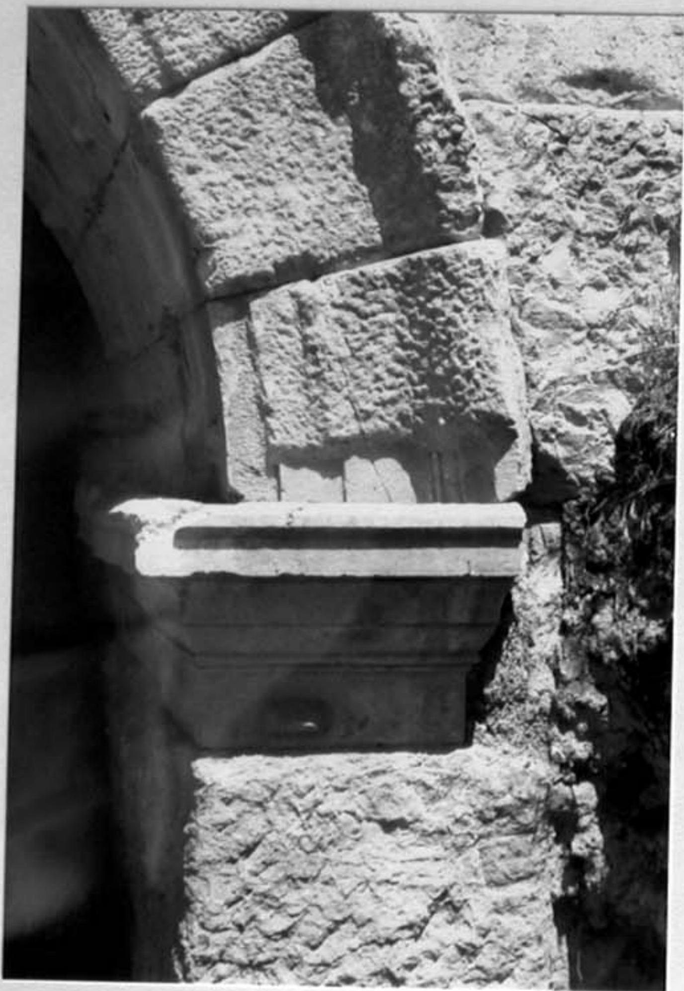
Abb. 34 Unvollendete Faszien der Archivolte des Gewölbes des östlichen Zugangs zur Cavea
