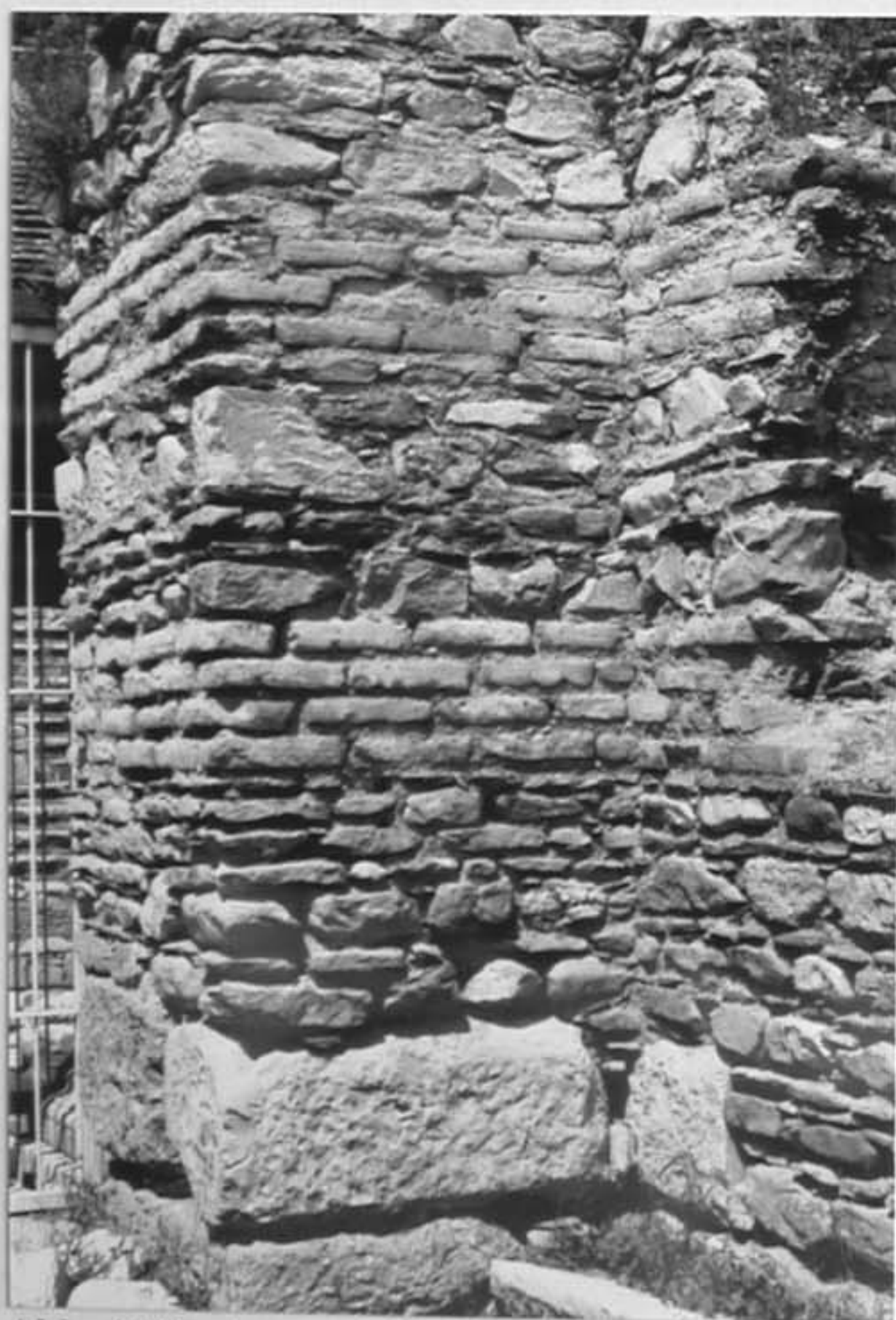
Abb. 42 Vorderwand des Bühnenhauses in opus mixtum
