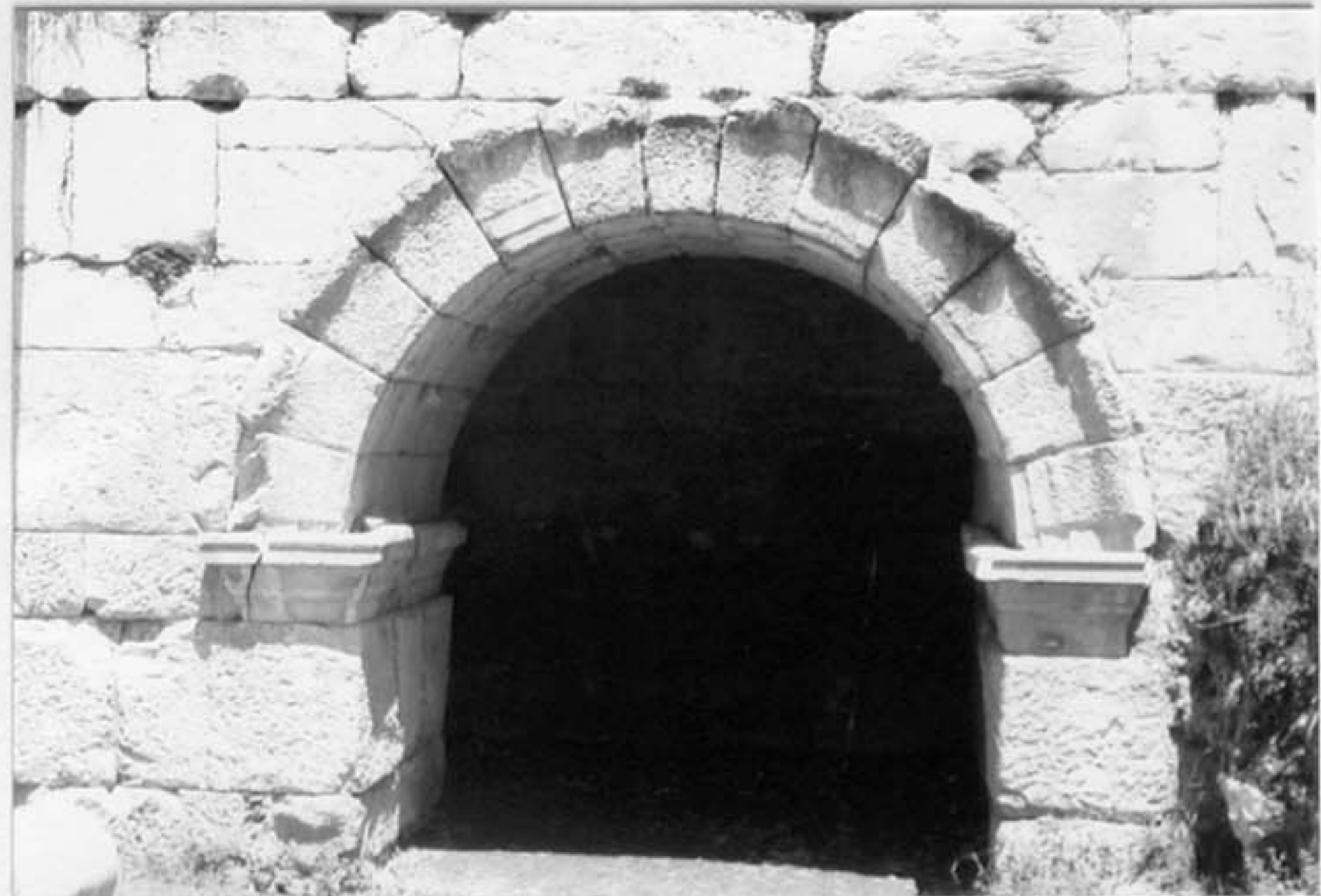
Abb. 33 Gewölbe des östlichen Zugangs zur Cavea
