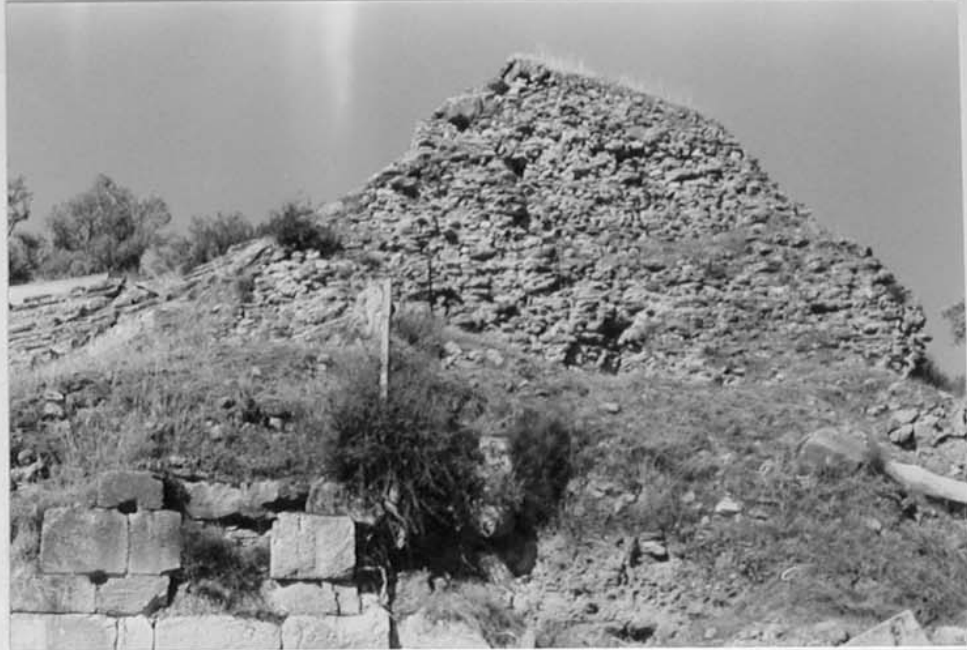
Abb. 28 opus incertum - Kern unter Sitzstufen der Cavea
