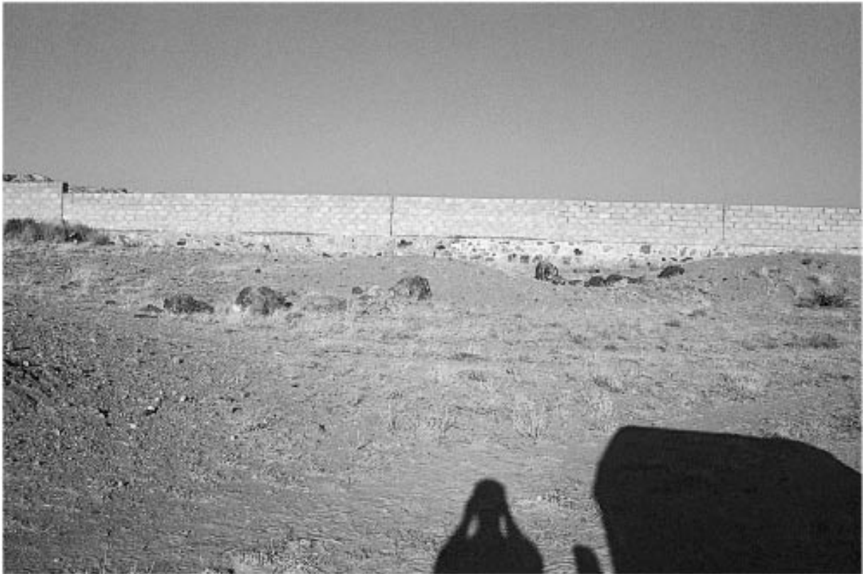
Abb. 54: Baubefund Shaabat Sulaiman B. Im Mittelgrund des Bildes eine Einfriedung eines gewerblich genutzten Geländes.
