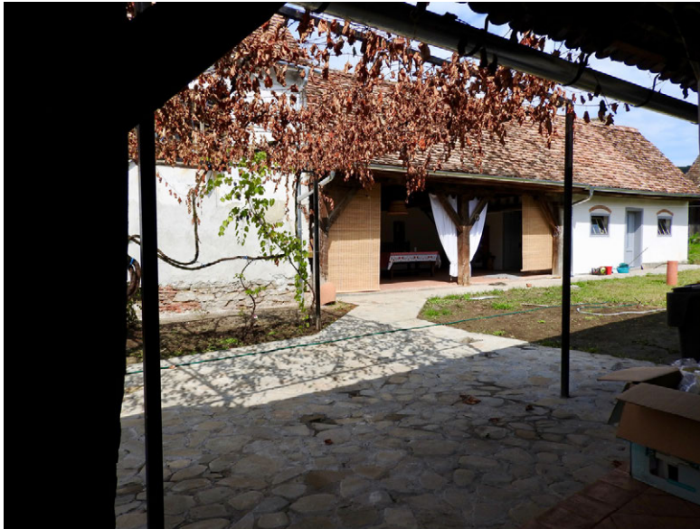
Abb. 10: Reichesdorf/Richiş Hausnr. 232. Schuppen und Wagenremise nach der Renovierung und dem Umbau zu einem kombinierten Küchen- und Essraum. Aufnahme privat 2019.
