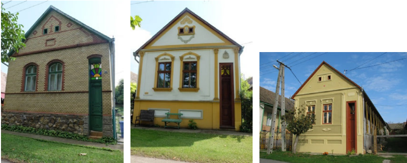
Abb. 19–23: Fassaden mit je zwei Fenstern und Lüftungslöchern und der Giebelseite proportional angepassten hohen, schmalen Gangstürchen
