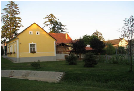
Abb. 15: Das Pfarrhaus nach der Renovierung 2004
