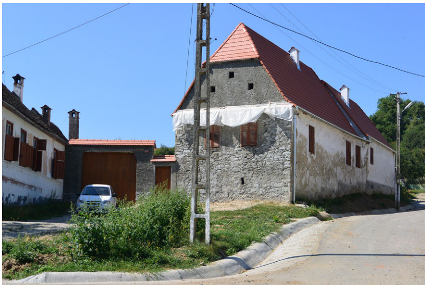
Abb. 13: Steinhaus der Familie Ehrlich/Rothmann in Zied/Veseud vom Ende des 16. Jahrhunderts, Hausnr. 57/112. Die Abwalmung des Giebels erfolgte im 18. Jahrhundert. Aufnahmen Werner Sedler, während der Restaurierung (2016).
