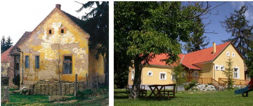
Abb. 103–104: Das Pfarrhaus vor und nach der Renovierung
