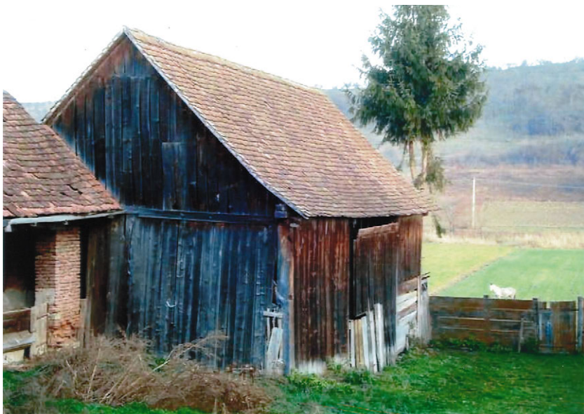
Abb. 14: Zied, Schneiderhof. Zustand vor der Renovierung. Aufnahme Werner Sedler, 2000.
