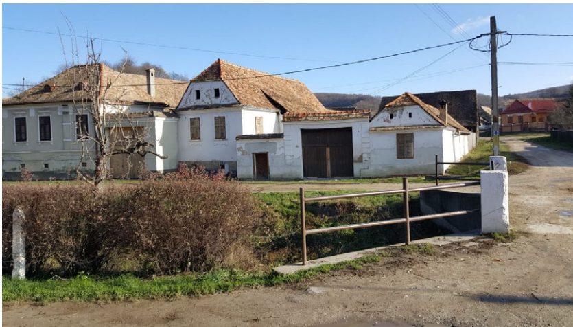
Abb. 8: Hochparterrehaus von 1820 in Reichesdorf/Richiș Hausnr. 232, heute als Sommerresidenz der Familie Ingrid und Stefan P. umgebaut. Aufnahme privat, 2019.
