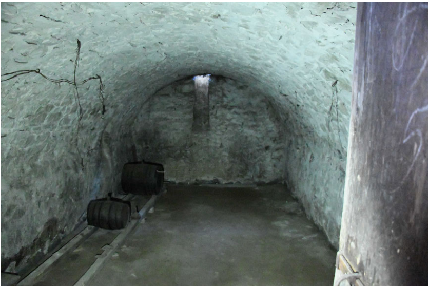
Abb. 32: Bolnisi: Gewölbekeller in dem Haus von Abb. 31, 2019
