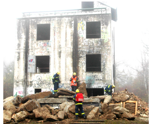
(b) Teilweise zerstörtes vierstöckiges Gebäude mit Randtrümmern, das der Ortungsübung diente.
