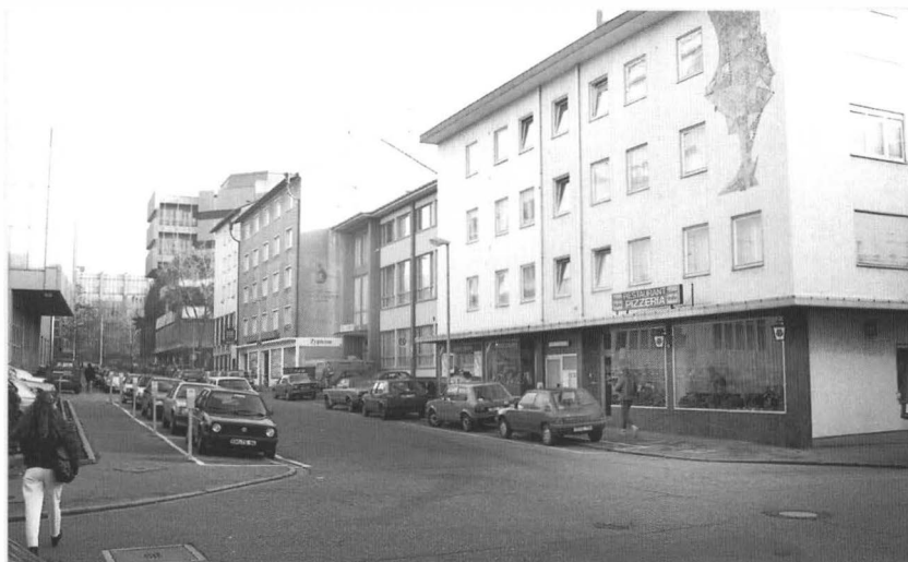
Das zwischen höheren Nachbarhäusern eingezwängte und zurückgesetzte Gebäude des ehemaligen „Foyer du Soldat“ in der Sedanstr. 6 (hier Bild aus dem Jahre 1988) dient heute der Universität für den Lehrbetrieb (Stadt:AF M 72 Neg. 1988/06/03 Nr. 47).
